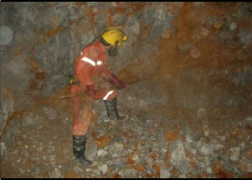
Trabajador con las protecciones adecuadas en pleno trabajo de tojeo.
